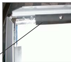
金具を取り外しLEDを交換
